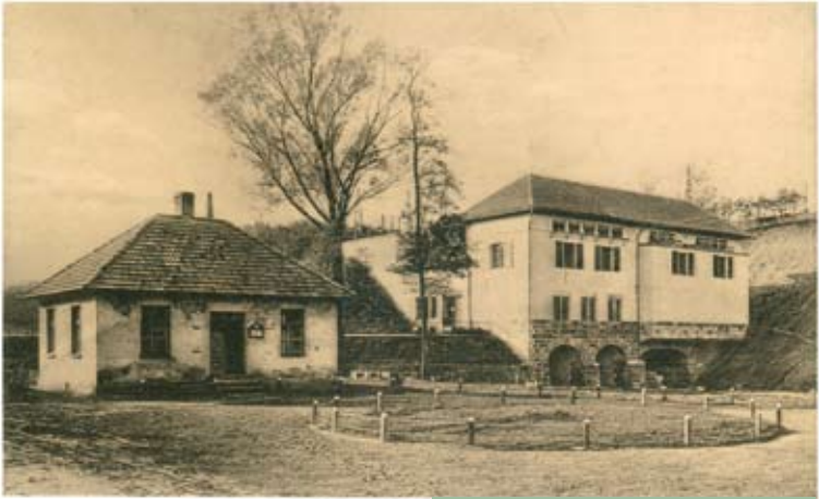
Elektrownia w Rutkach ok. 1910 r. (ze zbiorów prywatnych)
