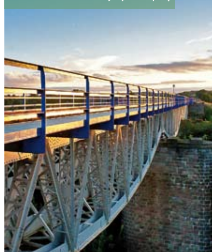
Wiadukt kolejowy nad Słupinią
